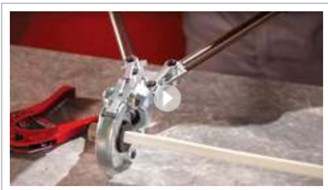
Монтаж металлопластиковых труб.
